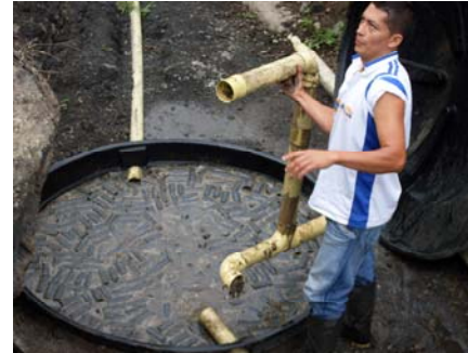
Retiro del distribuidor de flujo para eliminar obstrucciones de la tubería
