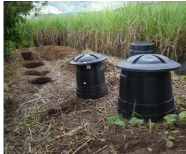
Localización, replanteo y excavación para montaje de los tanques
