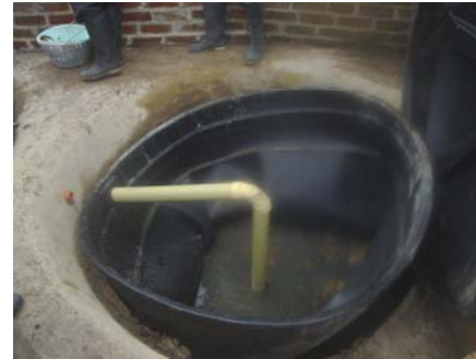
Deformación y levantamiento de tanques por infiltración de agua lluvia en las excavaciones que los alojan
