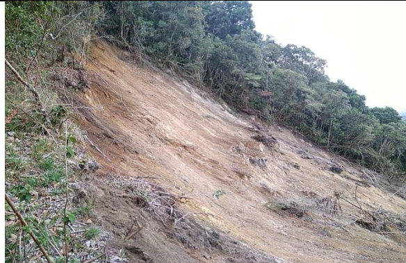
Imagen 2. Deslizamiento Vereda La Mina
