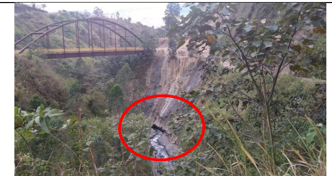
Imagen 4. Socavamiento al pie del talud.
