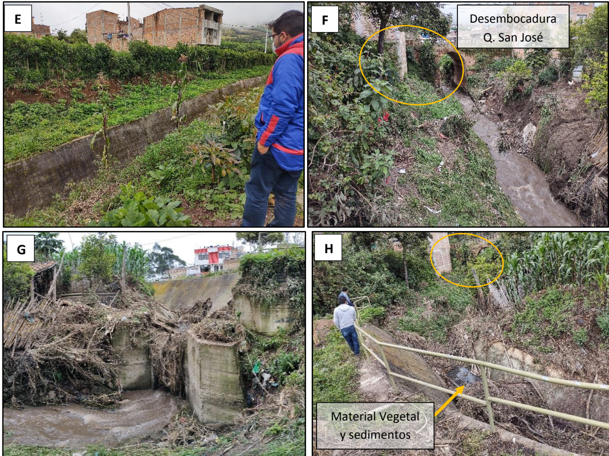
Figura 7. A – C. Agua represada quebrada San José - Urbanización San Nicolás. D. “canalización” puente de paso Quebrada San José – Urbanización San Nicolás. E. Canalización abierta Quebrada San José, casco Urbano. F. Zona que desemboca la Q. San José a la Q. Granadillo. G. Represamiento Box Couvert por material vegetal, sedimentos y basura. H. Material vegetal y sedimentos depositados por encima de box couvert.
