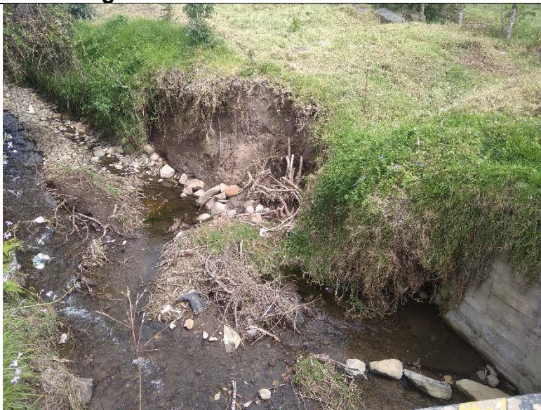
Imagen 6. Deslizamientos sector El Rosal.
