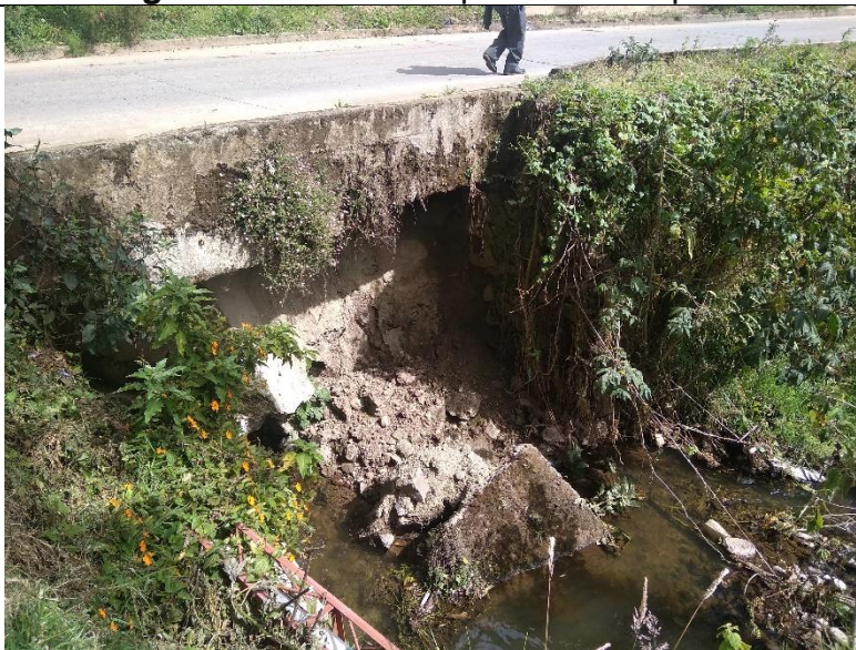
Imagen 4. Deslizamiento y daños en la base del muro en gaviones.
