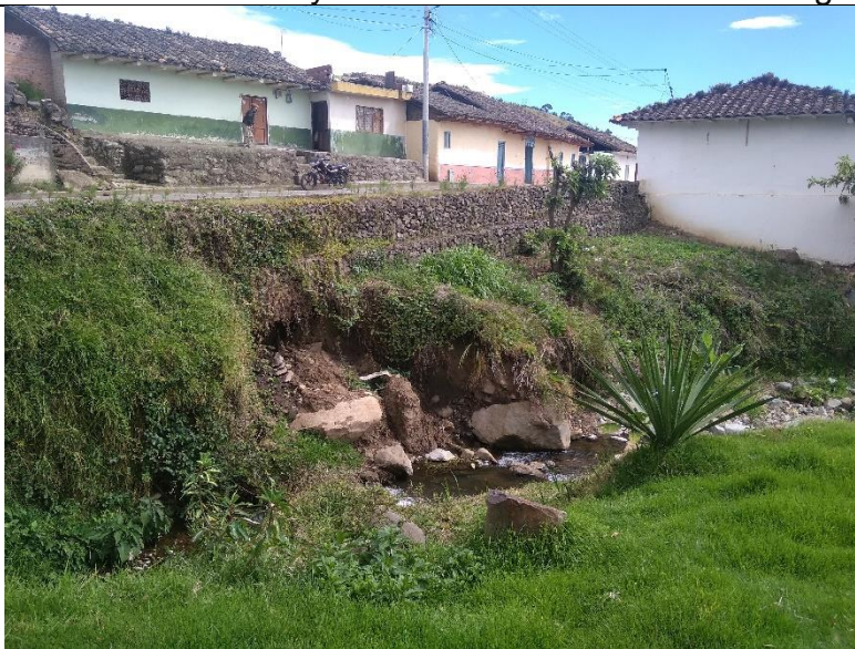
Imagen 4. Deslizamiento y daños en la base del muro en gaviones.
