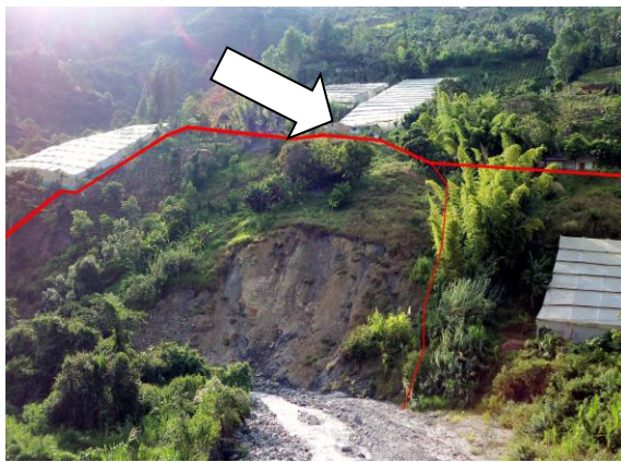
FOTOGRAFÍA 05. Vista del bloque de desplazamiento, dirección E-W.
