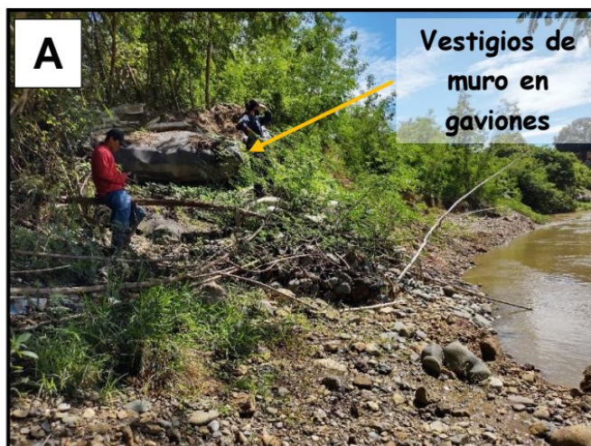
Imágenes 15. A. Vestigios muro en gaviones. B. Erosión lateral del río Patía.
