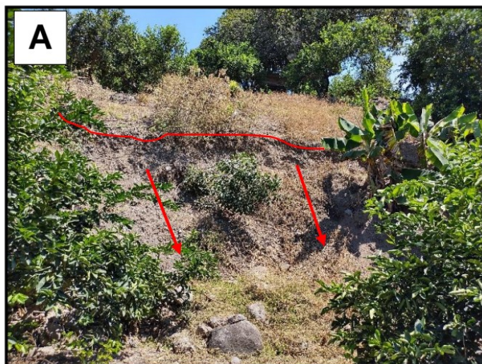
Imágenes 6: A – B. Escarpe zona media del talud, indicando la dirección del movimiento.
