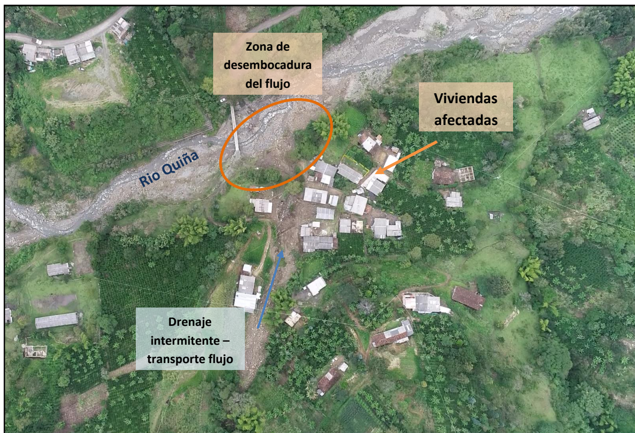
Figura 3. Viviendas afectadas del sector Los Castillos. Imagen tomada con DRONE de la DAGRD.
