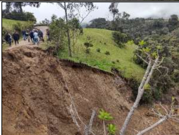
Figura 6. Movimiento en masa tipo flujo sector El Pueblito – Pérdida total de banca.
