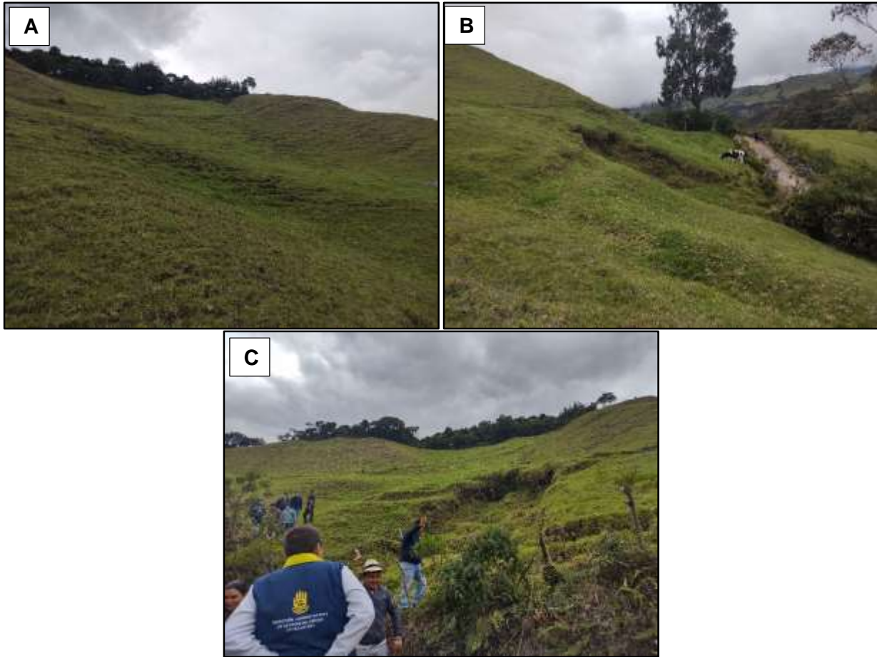
Figura 7. A. Procesos de reptación en la ladera. B – C. Procesos de reptación y hundimientos en el terreno.
