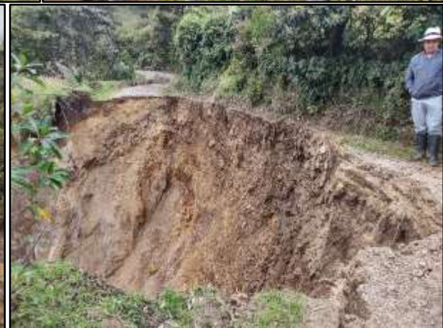
Figura 6. Movimiento en masa tipo flujo sector El Pueblito – Pérdida total de banca.
