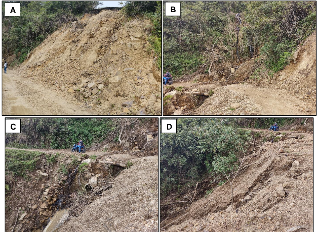
Figura 4. A – B. Vista general deslizamiento. C. Daños de tubería y estructuras de canalización de la quebrada. D. Deposito sobre la ladera.
