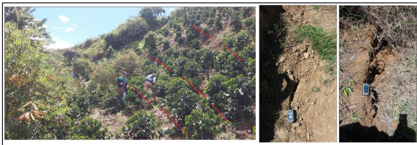
Figura 10. Agrietamientos en la ladera – vereda El Saladito. Tomado de informe SGC.
