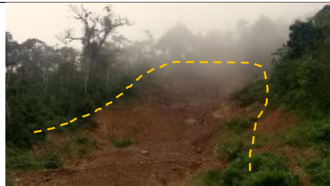
Imagen 3. Corona del deslizamiento.
