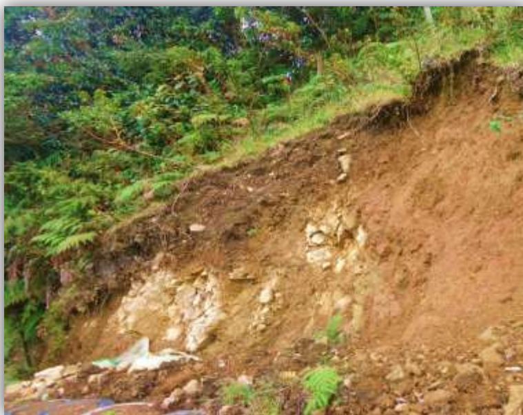
Figura 3. Afloramiento de rocas ígneas de composición andesítica en estado de meteorización y con diaclasamiento, localizadas en la parte media de la fuente de agua el Socorro.
