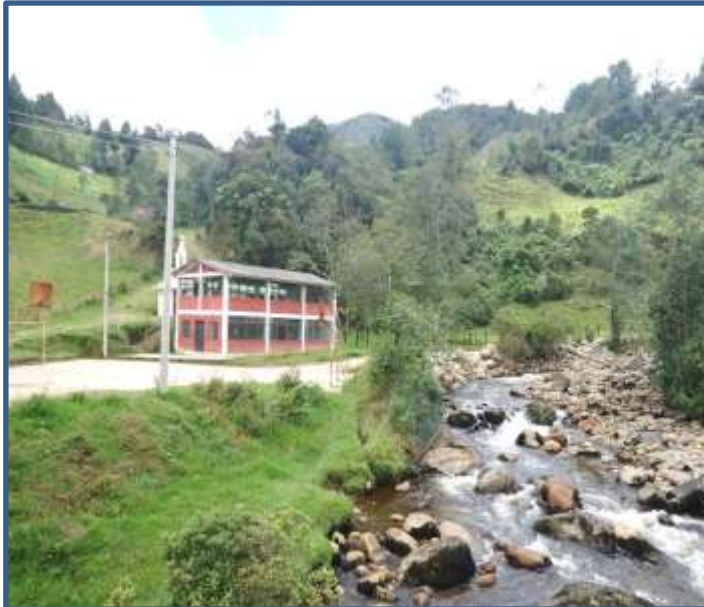
Figura 41. Edificaciones localizadas en terraza aledaña al cauce del Río encano y vía afectada por socavación lateral.
