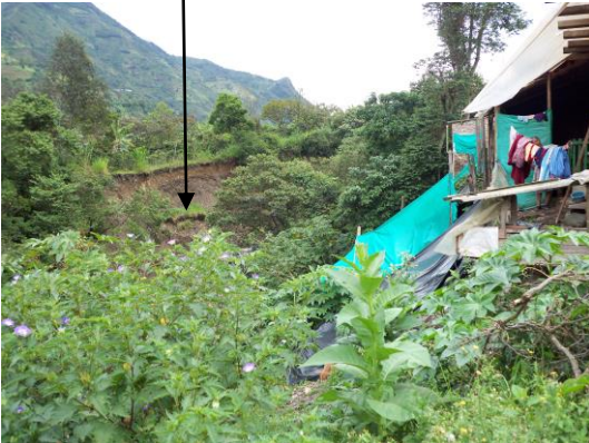
Fotografía No 6 Deslizamiento de talud y afectación a las casas quebrada El Rollo
