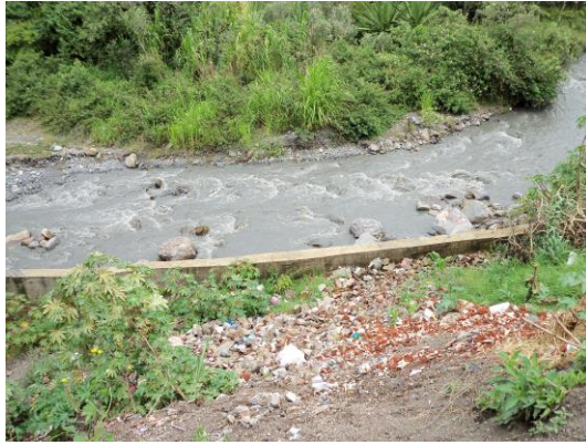
Fotografía No 5 Muro de concreto sector centro de acopio
