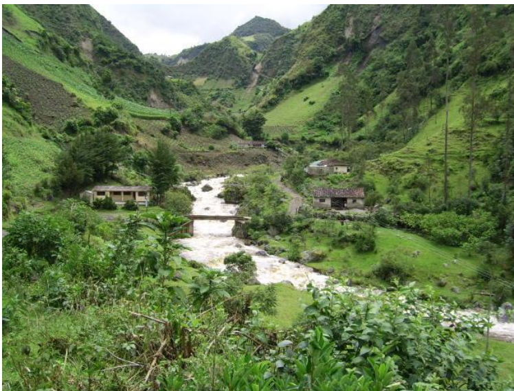
Fotografía 7. Observar las dos viviendas localizadas en la llanura de inundación del río Mayo, Centro Educativo Moncayo (izquierda).
