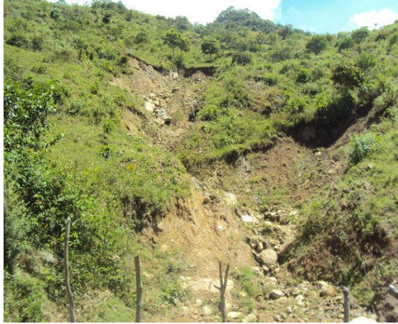
Evento No.1. Deslizamiento traslacional con caída de piedra.
