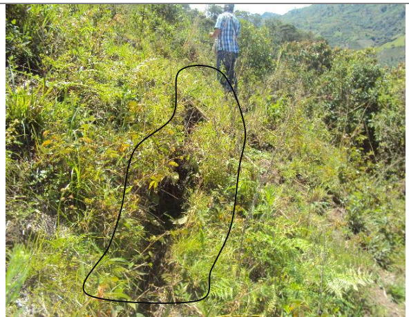
Grietas transversales sobre el terreno
