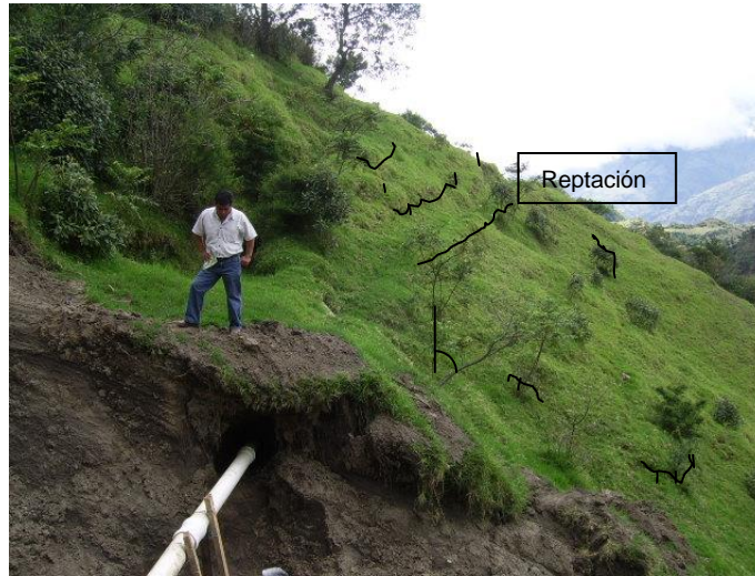
Fotografía 3. Observar los procesos erosivos en el predio aledaño al deslizamiento activo (reptación-formación de cárcavas)
