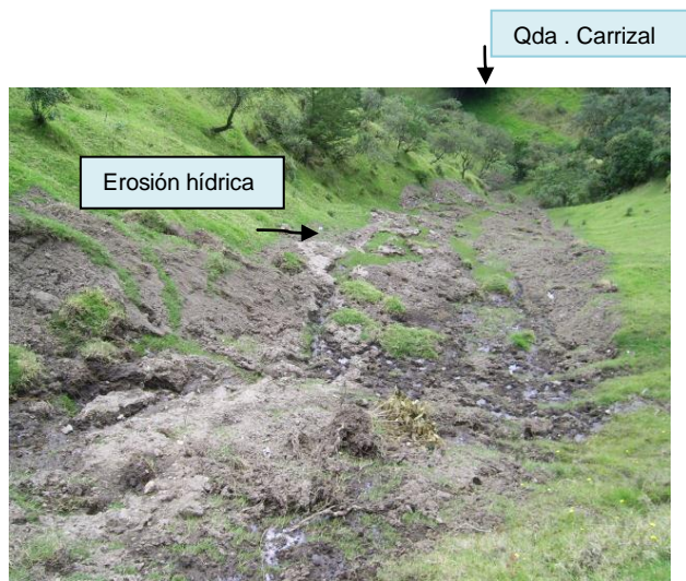
Fotografía 4. Observar el cuerpo del deslizamiento afectado por erosión hídrica.
