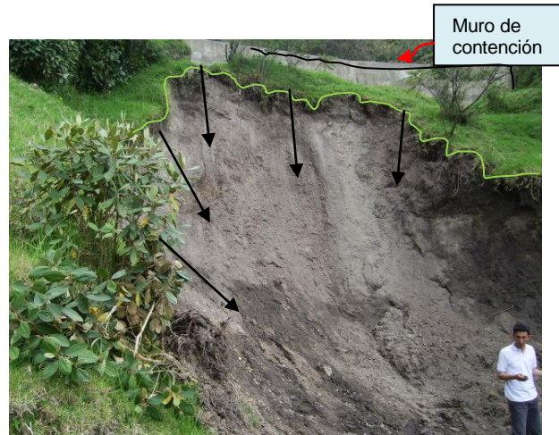
Fotografía 1. Corona de deslizamiento talud inferior vía Casco Urbano-Vereda La Estancia, municipio de La Cruz.
