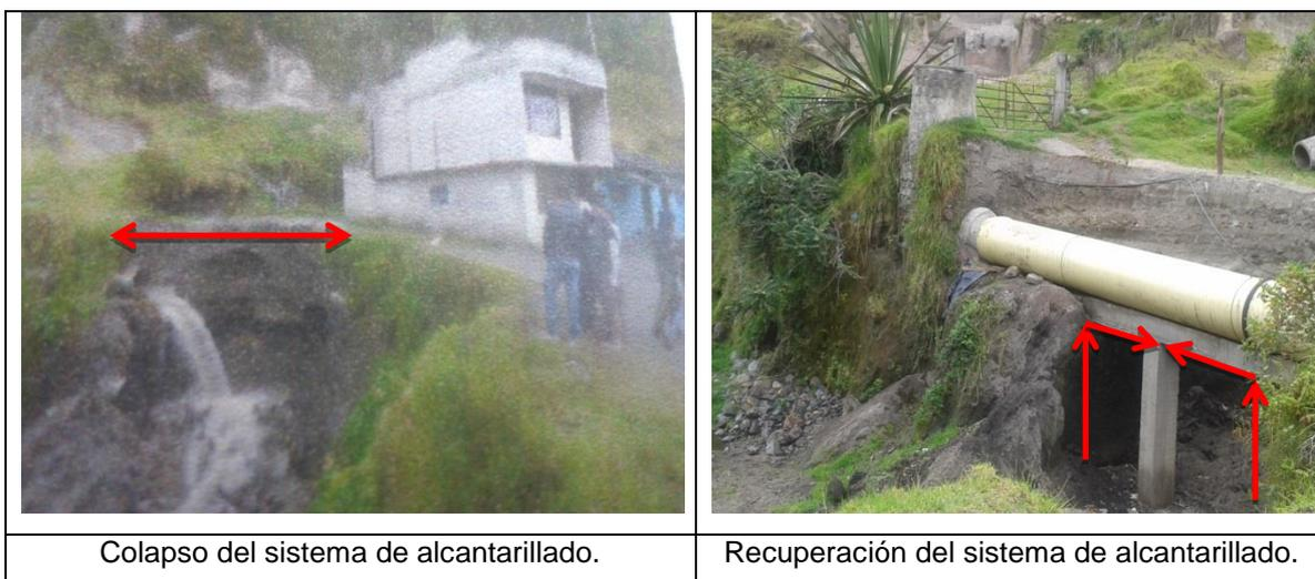
Al realizar el recorrido por la zona afectada, se evidenció el desarrollo paulatino de un proceso erosivo en el suelo que viene afectando la estabilidad de un puente, una cámara de inspección y la tubería del alcantarillado del municipio.
