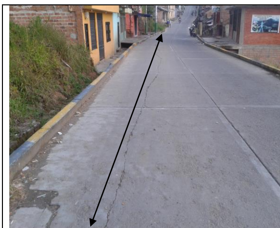
Fisura longitudinal presente sobre el pavimento, L= 28 m
