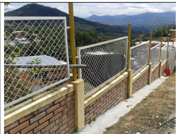
Cierre en Muro de ladrillo y malla
