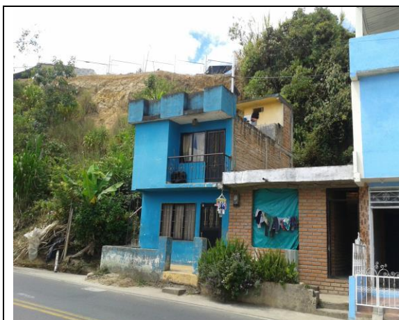
Viviendas de los Señores: José Marden M, Carlos Muñoz y Efrén Muñoz, Coordenadas Planas, E: 994.428, N: 668.684, altura de 1.742 m.s.n.m.
