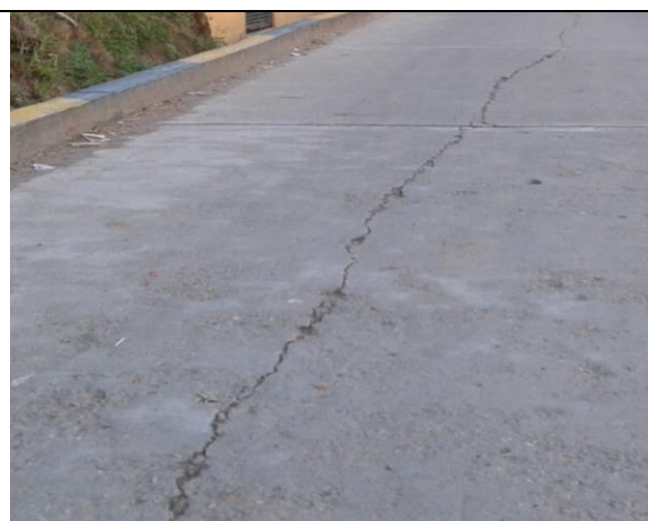
Fisura longitudinal presente sobre el pavimento, L= 28 m
