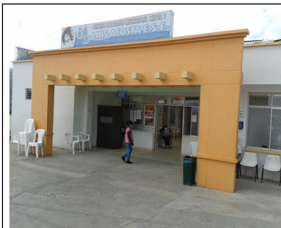
Instalaciones del Centro de Salud Nivel 1 “Luis Acosta” E.S.E.
