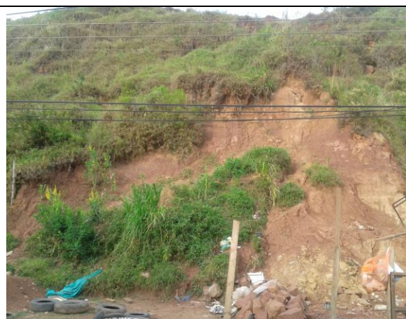
Deslizamiento rotacional de aprox. 140 m 3 , vivienda fue reubicada hace tres años.
