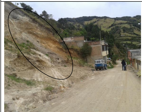
Deslizamientos de material
