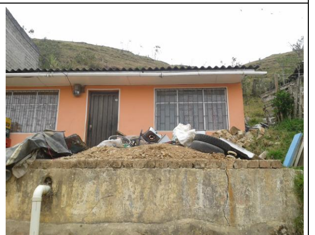
Viviendas ubicadas en la parte baja de la ladera
