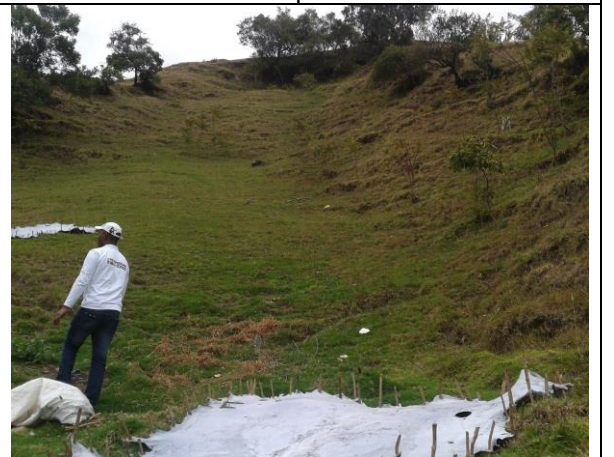
Asentamientos del terreno, altas pendientes y reptación.
