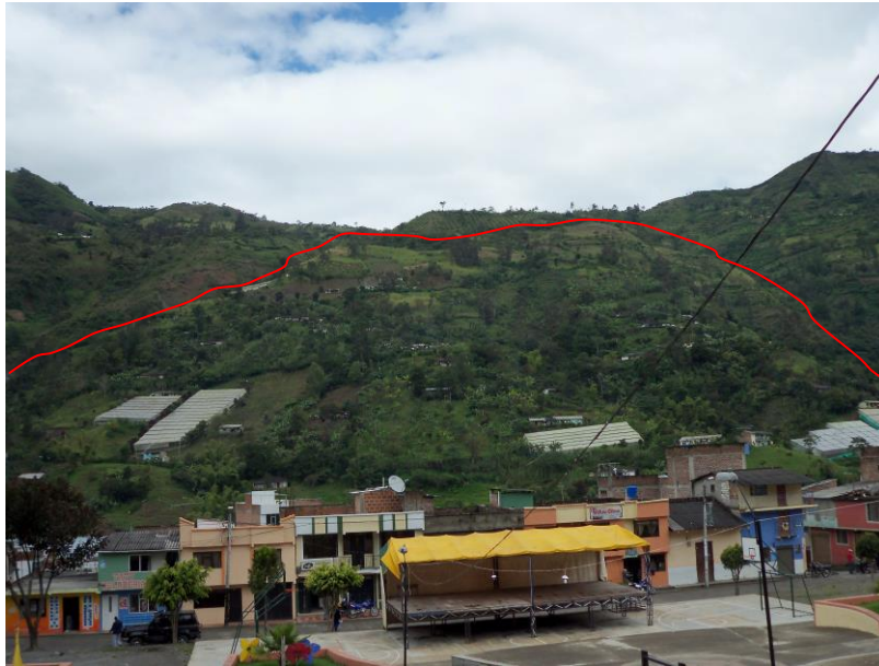
Fotografía No 1. Bloque que está en movimiento
