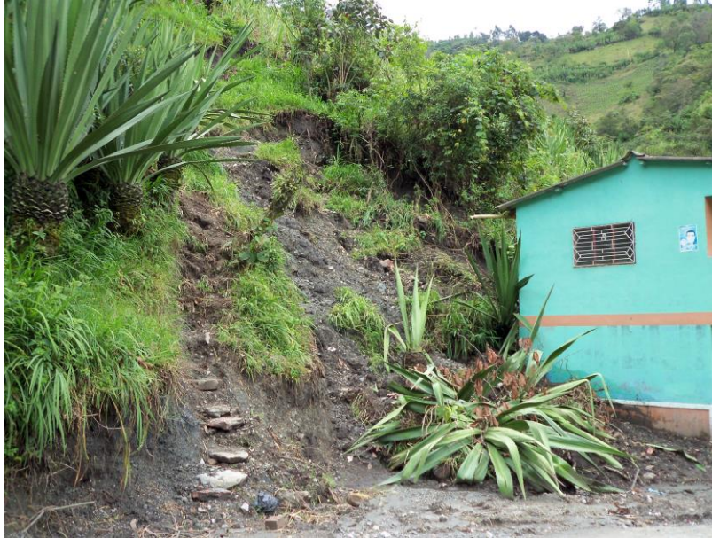
Fotografía No 5. Casa del señor Luis Delgado.
