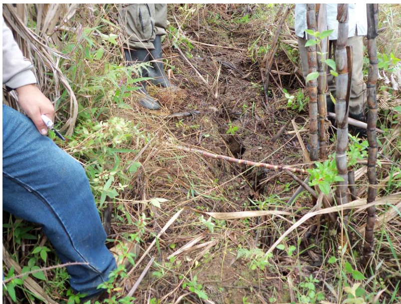
Fotografía No 4. Grietas en la parte superior del bloque.
