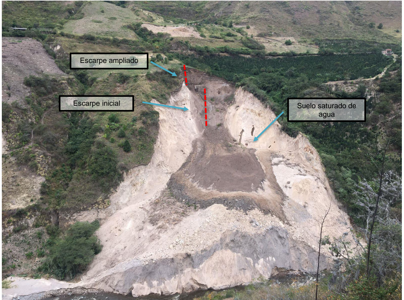
Figura 8. Estado de deslizamiento A. Escarpe inicial generado B y C. Material acumulado D. Estado actual del deslizamiento, nuevo escarpe generado.
