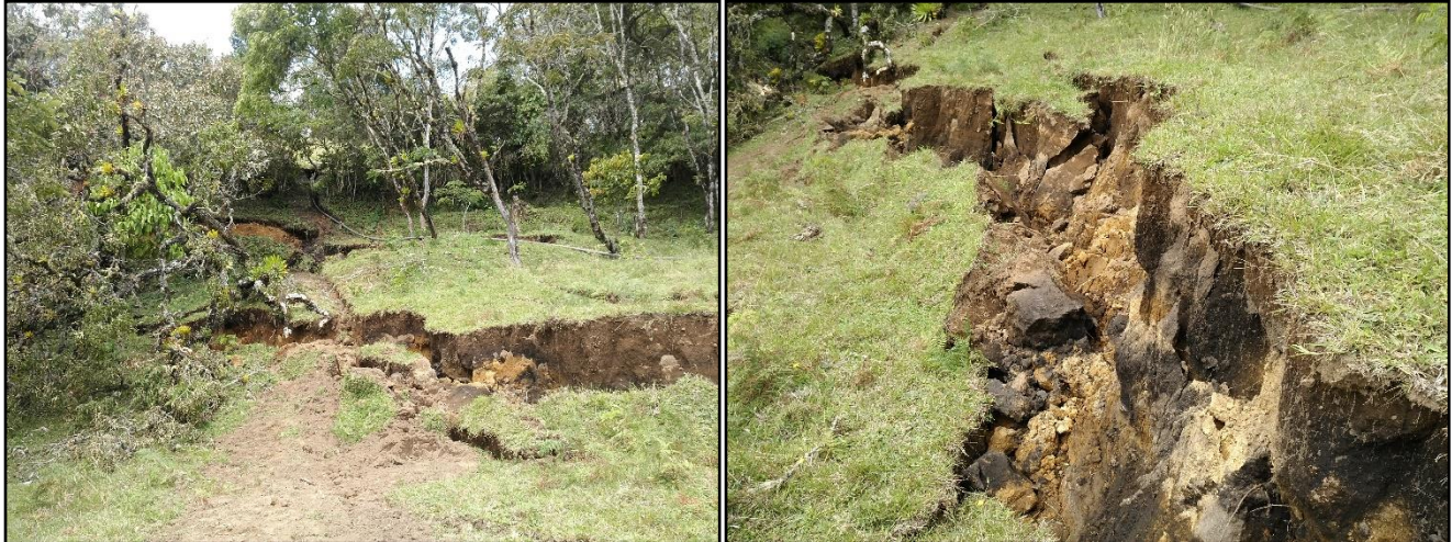
Figura 7. Agrietamientos reportados en el año 2017 por el equipo técnico de CORPONARIÑO.
