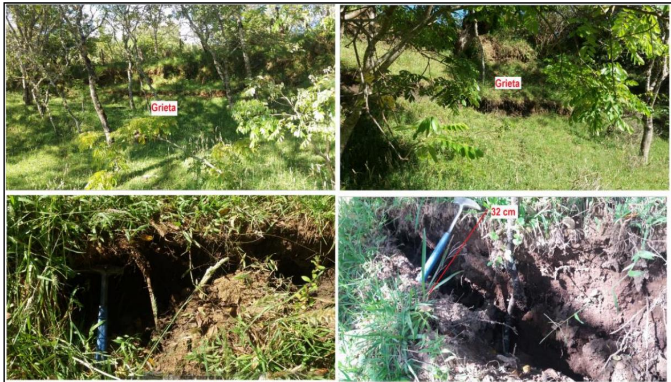
Figura 8. Hundimientos y agrietamientos registrados por SGC – Informe de Visita de Emergencia Municipio El Tambo – Veredas de Trojayaco y La Sultana año 2017.
