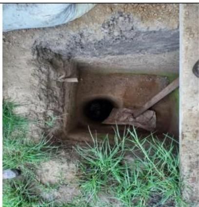
**Figura 169. Sistema Artesanal de Disposición final de vertimientos, barrio Mirador de Dios**
