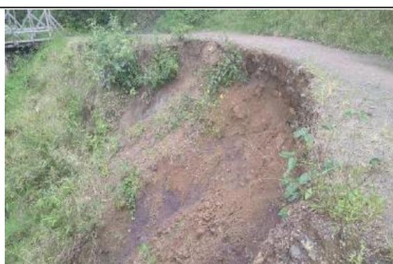
**Figura 103 Pérdida de banca y deslizamientos**
