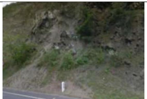
**Figura 127 Roca fracturada y caída de roca a la vía**
