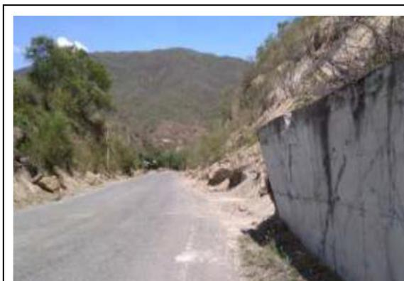
**Figura 126 Muro de contención dañado**
