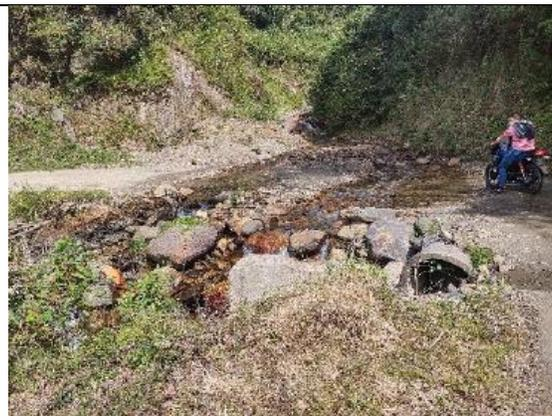
**Figura 21 Depósitos de flujos torrenciales sobre la vía**
