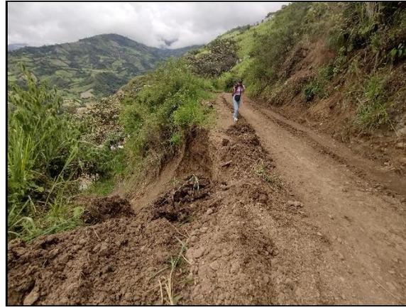
**Figura 154. Deslizamiento vereda Cocha Blanca**
