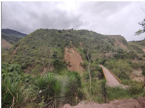
**Figura 151. Deslizamiento traslacional vereda El Limonar**
