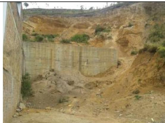
**Figura 119 Muro de contención y deslizamiento**
