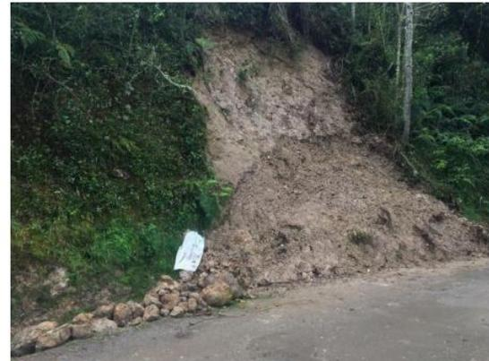
**Figura 172. Deslizamiento traslacional vereda Mojondinoy.**
