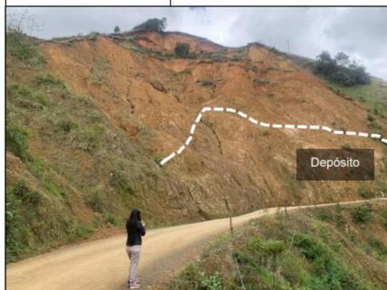
**Figura 204. Deslizamiento rotacional de gran magnitud vía Balalaica- Guachavés.**
