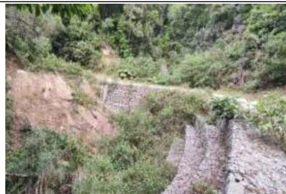
**Figura 32 Construcción muro de contención en gaviones Q. El Salado**
