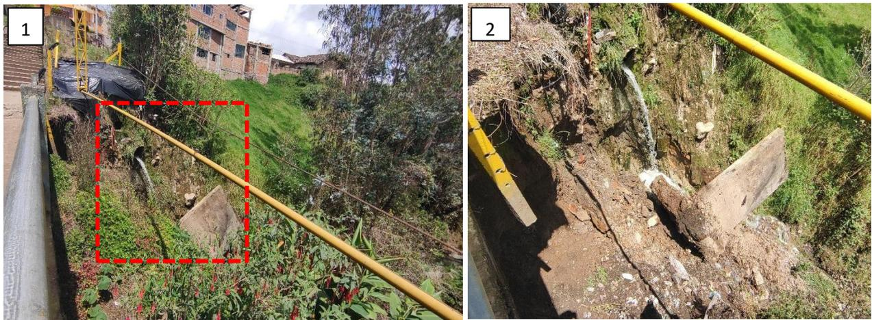
Imágenes 1 y 2. Muro de contención volcado y vertimientos directos al talud por las afectaciones en la tubería.
