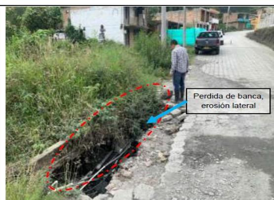
**Figura 84 Pérdida de banca y erosión lateral**
