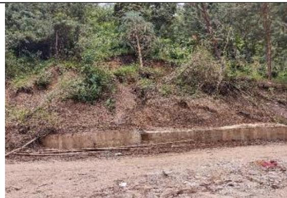
**Figura 109 Deslizamientos en la vía que comunica al puente La Rogelia**
