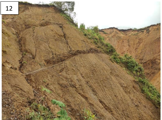
Imagen 11. Tomada del informe técnico 062/21. Imagen 12. Fotografía comparativa, tomada el día 02 de abril de 2022, se evidencia el deslizamiento activo, suelo saturado, escorrentía superficial y formación de surcos.
