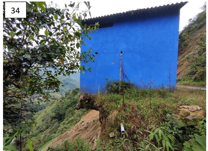
Imagen 33. Vista del deslizamiento desde Desmontes Bajos. Imagen 34. Afectaciones en la estructura del acueducto.
