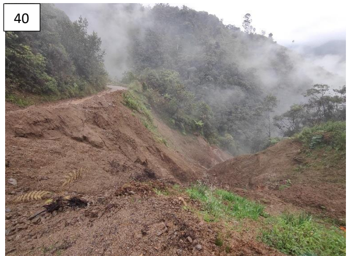
Imágenes 39 y 40. Deslizamiento rotacional con flujo de tierra que ocasionó la pérdida de banca.
