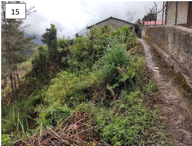
Imagen 15. Tomada del informe técnico 062/21. Imagen 16. Fotografía comparativa, tomada el 02 de abril de 2022. Parte lateral de la escuela y camino de ingreso a una vivienda, ubicados sobre corona de talud inestable.
