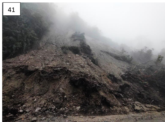
Imagen 41 y 42. Sector donde se presentó el deslizamiento traslacional con flujo de detritos que obstruyó la vía hacia el corregimiento de Monopamba.
