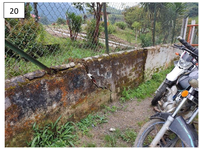
Imagen 19. Habitantes del sector construyendo un sendero en el escarpe del deslizamiento. Imagen 20. Grietas en la infraestructura de la escuela de la vereda Desmontes Bajos.
