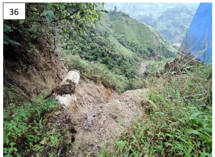
Imagen 35. Sistema de acueducto y alcantarillado. Imagen 36. Inadecuado manejo de aguas desestabilizando el terreno.
