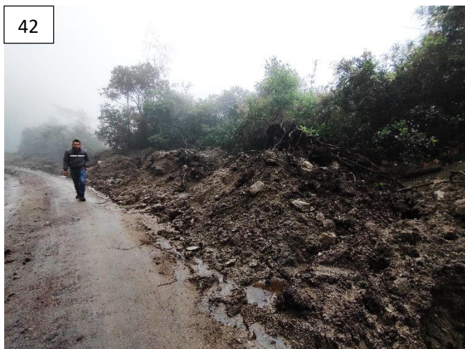
Imagen 41 y 42. Sector donde se presentó el deslizamiento traslacional con flujo de detritos que obstruyó la vía hacia el corregimiento de Monopamba.
