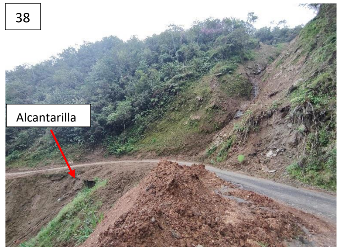
Imagen 37. Aporte de sedimentos a la quebrada El Peje. Imagen 38. Deslizamiento rotacional con flujo de tierras, alcantarilla que fue obstruida el día del evento.
