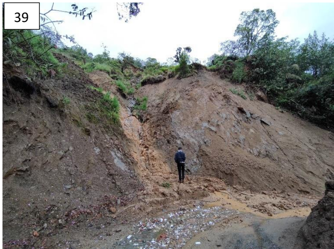
Imágenes 39 y 40. Deslizamiento rotacional con flujo de tierra que ocasionó la pérdida de banca.
