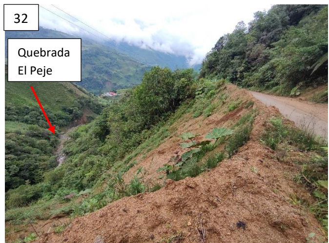
Imágenes 31 y 32. Deslizamiento rotacional, se evidencia material de aporte a la quebrada El Peje.
