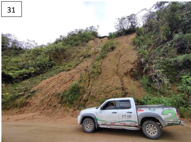
Imágenes 31 y 32. Deslizamiento rotacional, se evidencia material de aporte a la quebrada El Peje.
