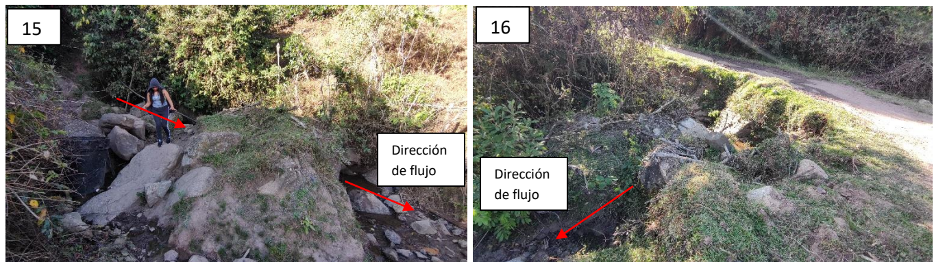
Imágenes 15 y 16. Obstrucción y represamiento de material inconsolidado y detritos leñosos en el cauce de una quebrada no identificada.
