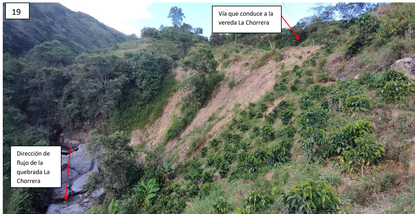
Imagen 19. Deslizamiento rotacional retrogresivo en la vía que comunica la vereda La Chorrera con la vía principal del municipio de San Pablo.
