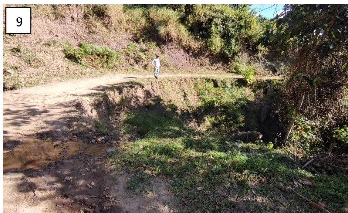
Imagen 8. Alcantarilla completamente obstruida, con hundimiento y estancamiento de agua. Imagen 9. Perdida de banca.
