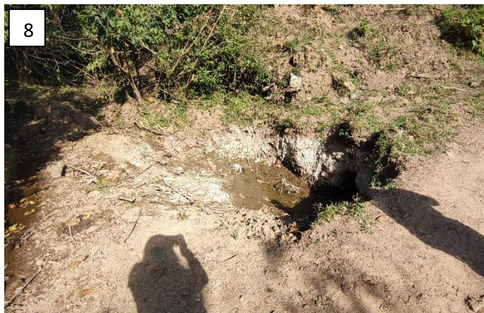
Imagen 8. Alcantarilla completamente obstruida, con hundimiento y estancamiento de agua. Imagen 9. Perdida de banca.
