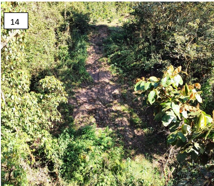
Imágenes 10 – 14. Deslizamientos traslacionales identificados en predios con cultivos de café y que generan aporte de sedimentos a la quebrada no identificada.
