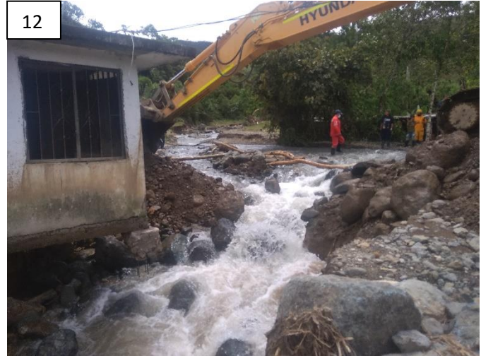
Imagen 11. Zona de represamiento parte baja de la quebrada. Imagen 12. Desvío quebrada La Barrosa, dejando expuestos los cimientos de una vivienda afectada.
