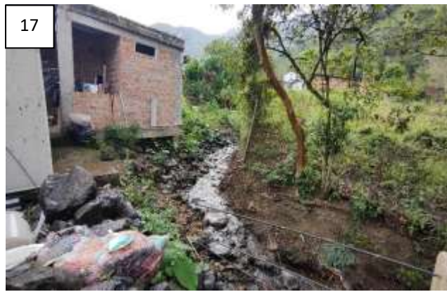
Imagen 16. Fotografía donde se evidencia la construcción inadecuada de viviendas al borde de la quebrada, generando una condición de riesgo.
