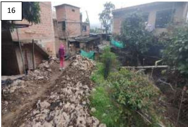
Imagen 16. Fotografía donde se evidencia la construcción inadecuada de viviendas al borde de la quebrada, generando una condición de riesgo.
