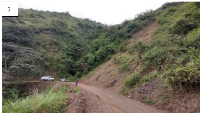
Figura N. 5. Cobertura con vegetación secundaria área del talud.
