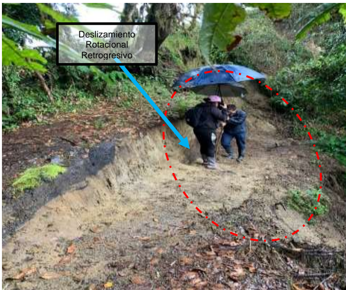
Zona donde se evidencia, Agrietamiento profundo se observa deslizamientos Rotacionales, Pérdida de banca, Acumulación de material vegetal en el Cerro Chimayoy.
