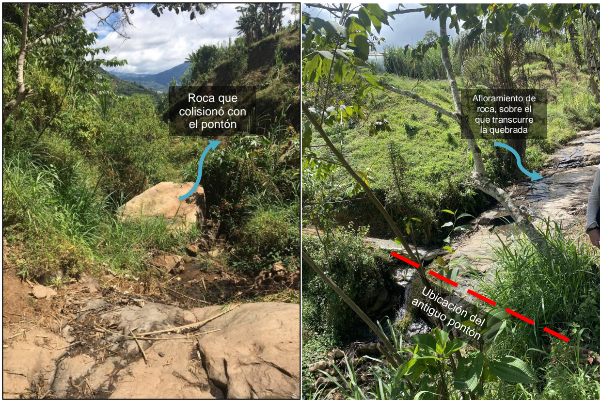
Figura 3. Localización antiguo pontón, vereda La Florida
