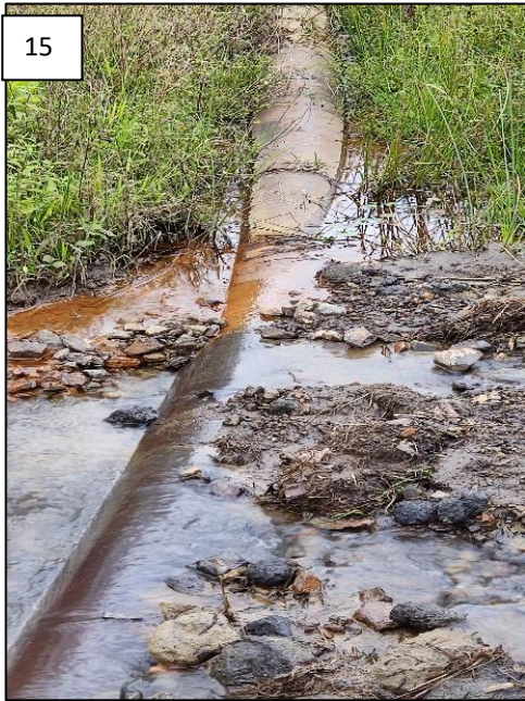
Imagen 15. Flujo parte baja sobre tubería de Oleoducto transandino. Imagen 16. Agrietamiento y reptación
