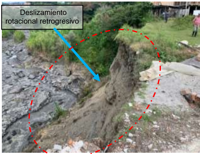
zona que presenta, Deslizamiento rotacional retrogresivo, Grietas
