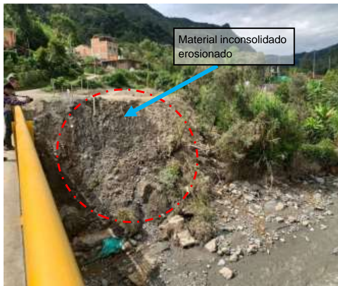
Zona que presenta, Perdida de banca, Deslizamiento rotacional retrogresivo
