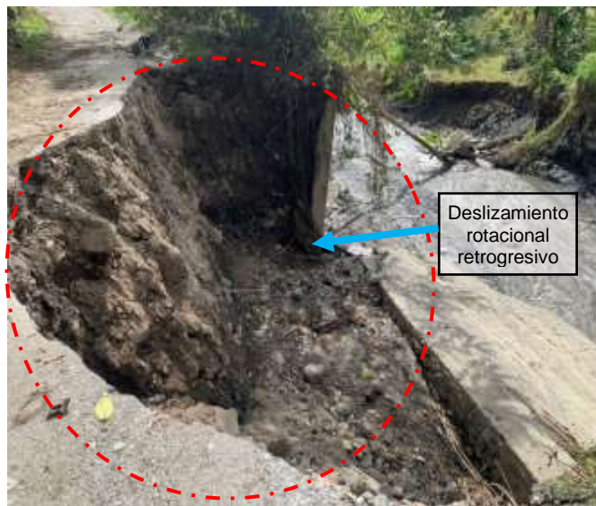
Zona que presenta, Perdida de banca, Deslizamiento rotacional retrogresivo
