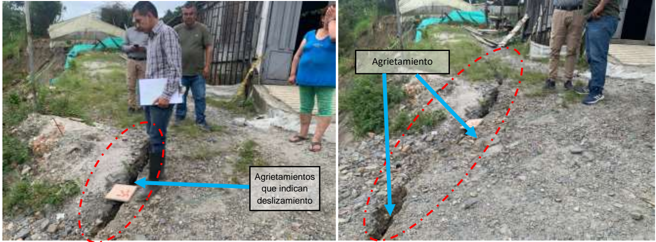
Agrietamientos en la corona del deslizamiento rotacional retrogresivo
