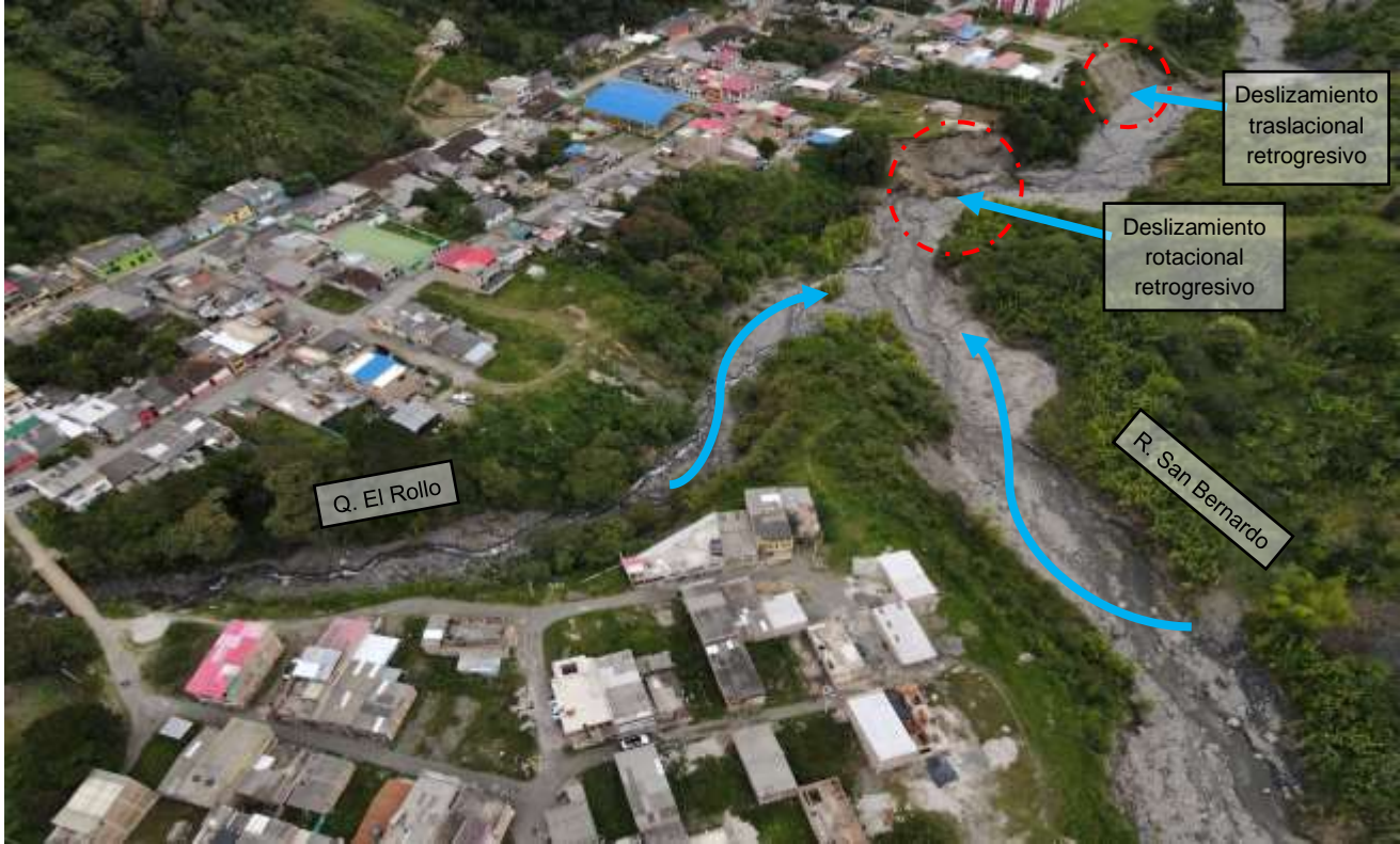
Zonas donde se presentan deslizamientos rotacionales retrogresivos a lo largo del cauce del río El San Bernardo.
