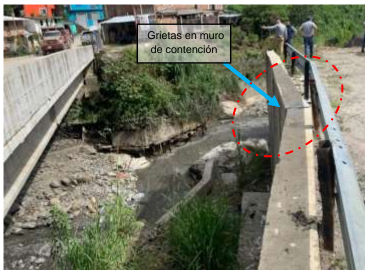
Zona que presenta, Deslizamiento rotacional retrogresivo, Acumulación de sedimentos
