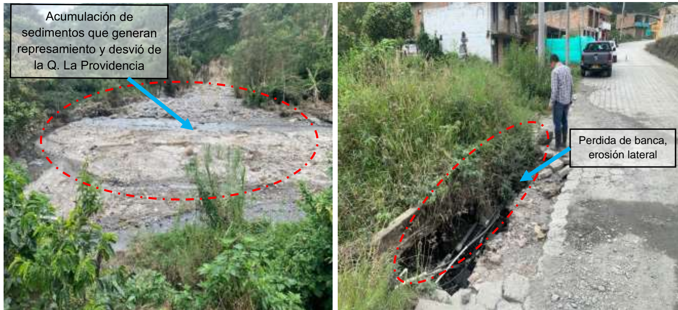
Zona que presenta, acumulación de sedimentos, desprendimiento de material, pérdida de banca
