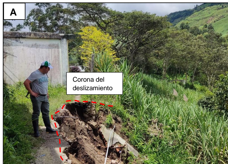
Figura 15. A. Deslizamiento debido a la carga de agua superficial, mal manejo de las mismas y la posible ruptura de una tubería de agua potable que pasa por el lugar, se presentó colapso de muro de cierre y andén en el Colegio san Francisco.
