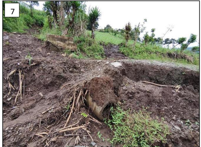
Imagen 6. Vertimientos directos al deslizamiento por tubería. Imagen 7. Alcantarilla colapsada.
