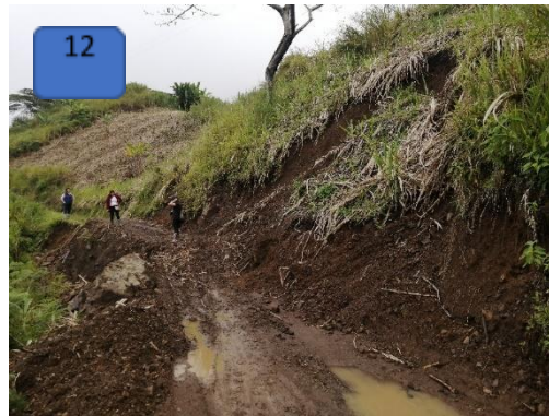
Figuras. 8,9,10,11,12. Afectación vereda Catauca, municipio de La Florida.
