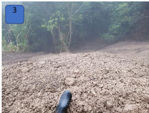
Imágenes. 1, 2, 3. Afectación por movimiento en masa en la vereda Yunguilla municipio de La Florida.
