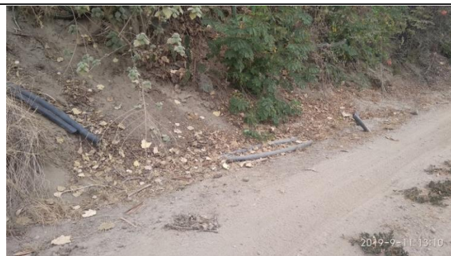
Imagen 3. Mangueras rotas.
