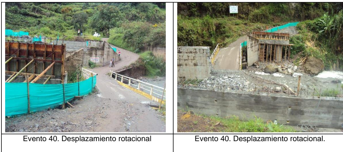
Este movimiento corresponde a un desplazamiento rotacional, ubicado sobre el margen derecho, aguas abajo del río Mayo. Para efectos de la cubicación de este evento se tiene los siguientes datos:
