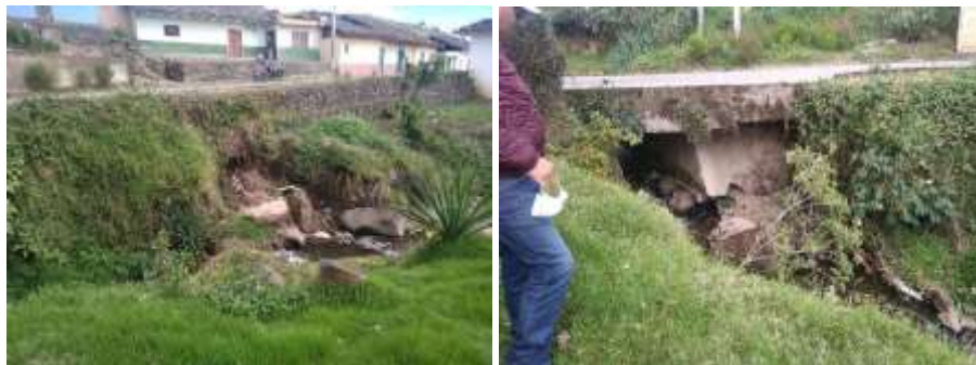
Figura 37. Depósitos de escombros.
