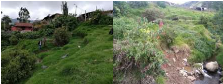
Figura 35. Zonas de erosión lateral.
