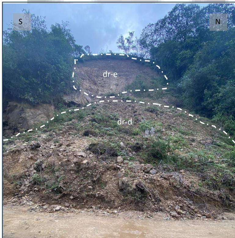
**Figura 42 Deslizamiento rotacional retrogresivo. A. ESTACIÓN KNK0015 B. ESTACION KNK0025**
