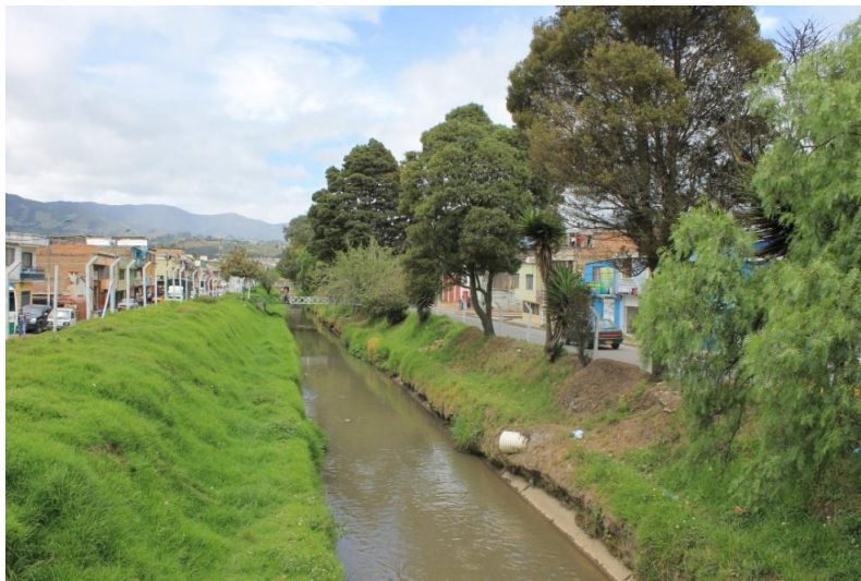
Figura 16. Canalización del río Miraflores.
