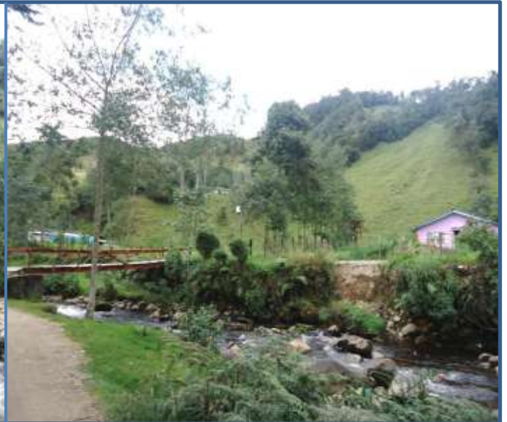
Figura 40. Viviendas ubicadas sobre depósitos de antiguas avenidas torrenciales y puente en posible riesgo.
