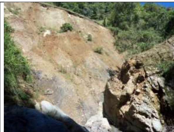
Evento 28. Deslizamiento Rotacional.
