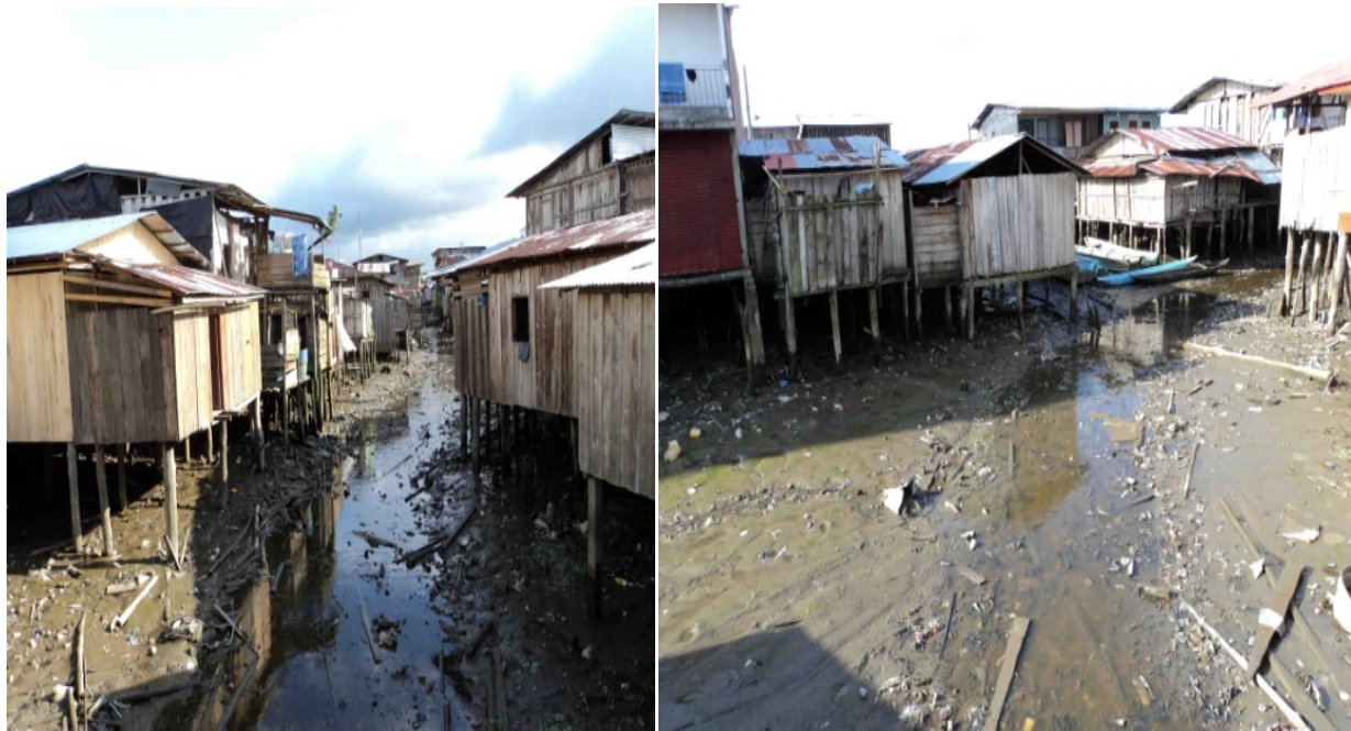
Figura 39. Afectación Barrio La Pista municipio de Olaya Herrera.
