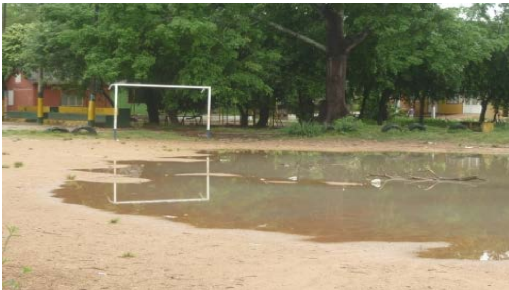
Figura 45. Infraestructura afectada sub-zona 2 polideportivo municipio de Olaya Herrera
