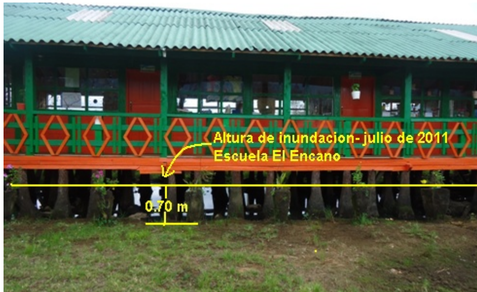
Figura 108. Estado infraestructura, escuela El Encano, corregimiento El Encano, municipio de Pasto.
