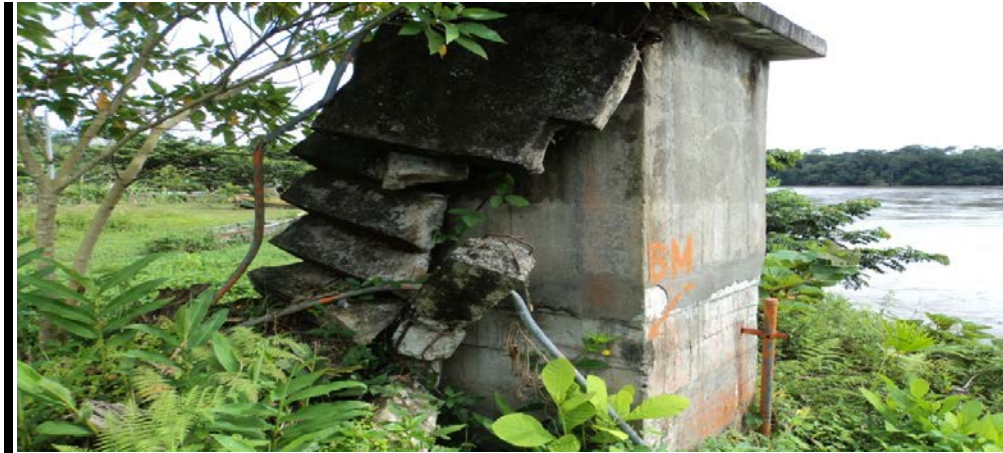
Figura 53. Estado actual de la estación San Juan río Mira sector imbilí Candelillas municipio de Tumaco.
