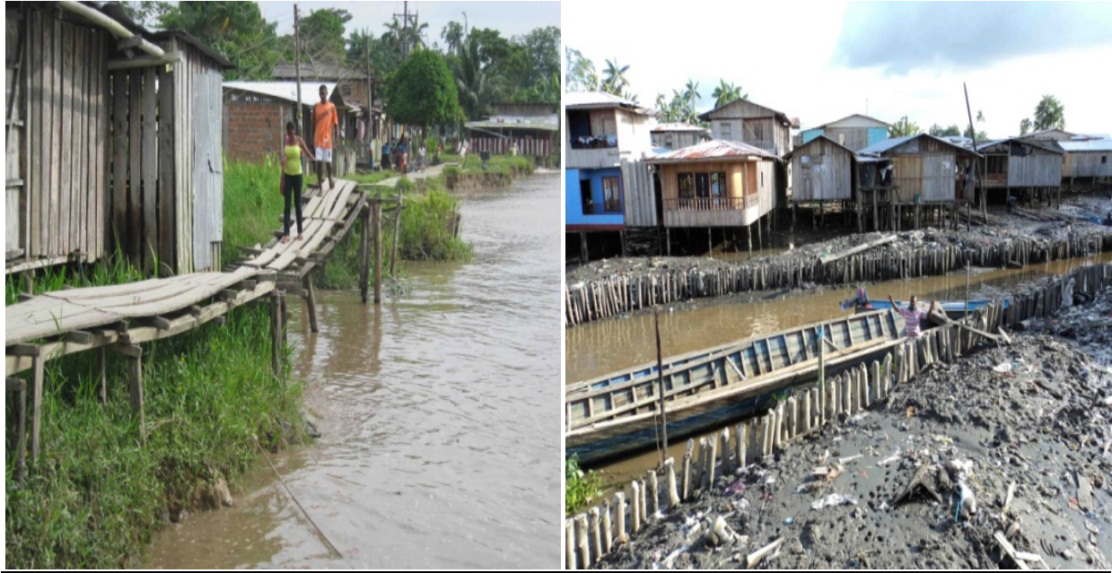
Figura 38. Afectación Barrio El Balso municipio de Olaya Herrera.
