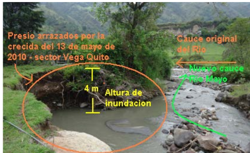
Figura 101. Estado infraestructura predios cercanos ribera del río Mayo, municipio de San Pablo.
