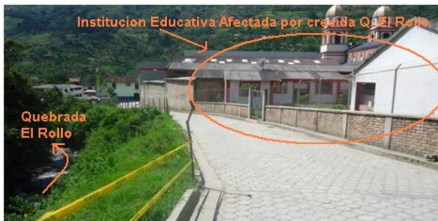
Figura 89. Estado actual institución educativa municipio de San Bernardo
