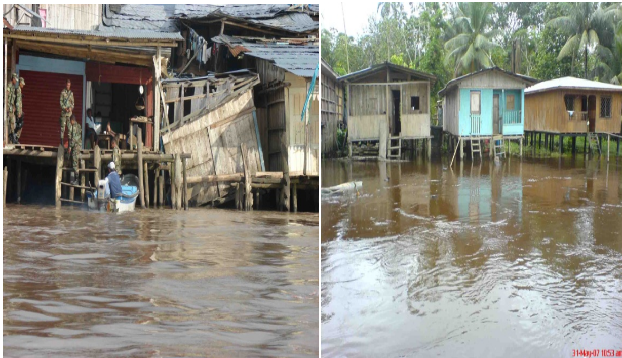
Figura 35. Edificaciones Típicas municipio Olaya Herrera. Fuente: CLOPAD.
