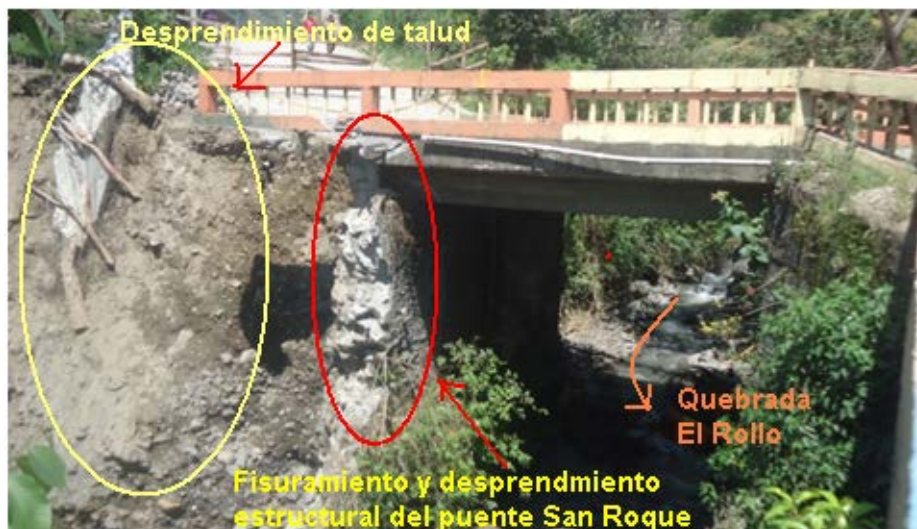
Figura 90. Estado actual puente San Roque municipio de San Bernardo
