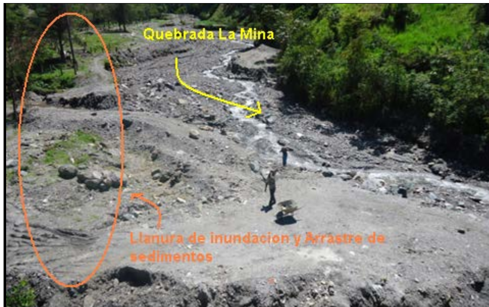
Figura 79. Marca histórica de inundación aguas arriba Quebrada la Mina, sector La Vega municipio de San Bernardo
