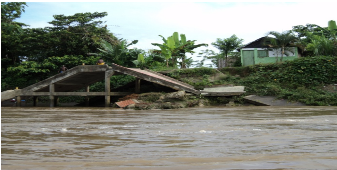
Figura 62. Infraestructura muelle sector Imbilí Candelillas municipio de Tumaco.
