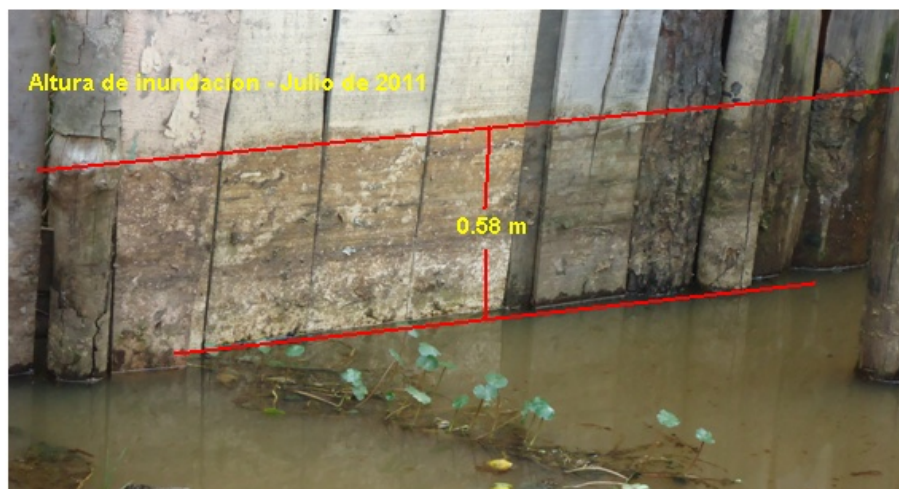
Figura 103. Marcas históricas de inundación vereda EL Puerto, corregimiento El Encano, municipio de Pasto.
