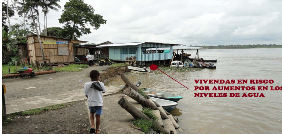
Figura 30. Viviendas en riesgo por socavación lateral de cauce río Patía
