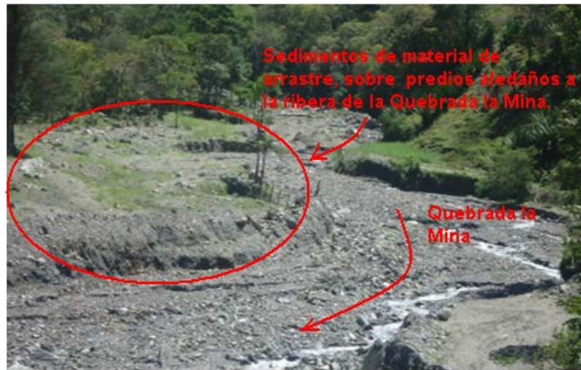
Figura 83. Estado actual sector vereda La Mina municipio de San Bernardo
