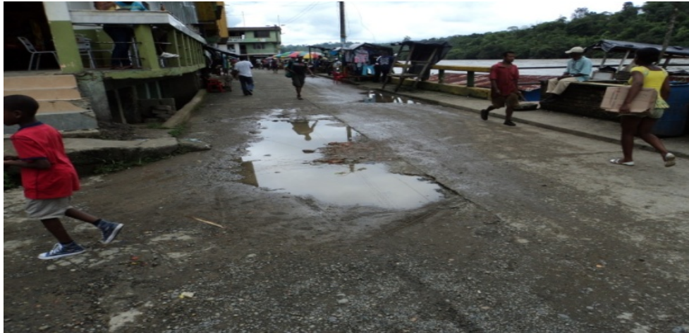
Figura 76. Infraestructura vía cabecera municipal de Barbacoas.
