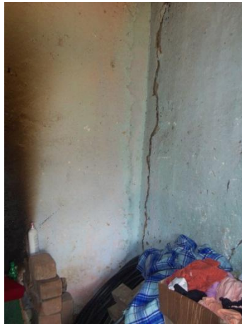
Fotografías 47 y 48. Vivienda Señorara. Maria Gutiérrez. Se presenta fisuramiento en muros. Corresponde a una construcción con muros en adobe y cubierta de teja de barro sobre estructura en madera rolliza. Tiene una antigüedad mayor a 30 años.
