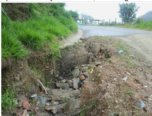
Fotografía 77. EVENTO 08. Indica el asentamiento de la banca de la vía en el sector. (a= 0.65 m)
