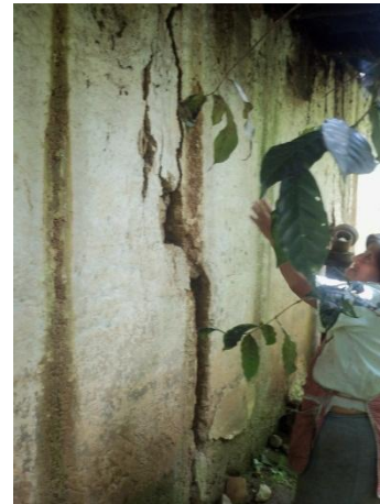
Fotografías 47 y 48. Vivienda Señorara. Maria Gutiérrez. Se presenta fisuramiento en muros. Corresponde a una construcción con muros en adobe y cubierta de teja de barro sobre estructura en madera rolliza. Tiene una antigüedad mayor a 30 años.
