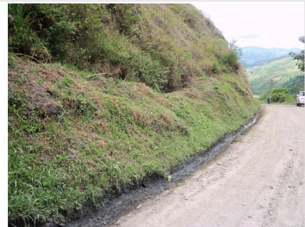
Fotografías 33 y 34. EVENTO 29. La altura del evento es de 80.0 \text{ m} , tiene un ancho de 51.0 \text{ m} . El volumen deslizado corresponde a 2.180 \text{ m}^3 y presenta una superficie afectada de 4.350 \text{ m}^2 .
