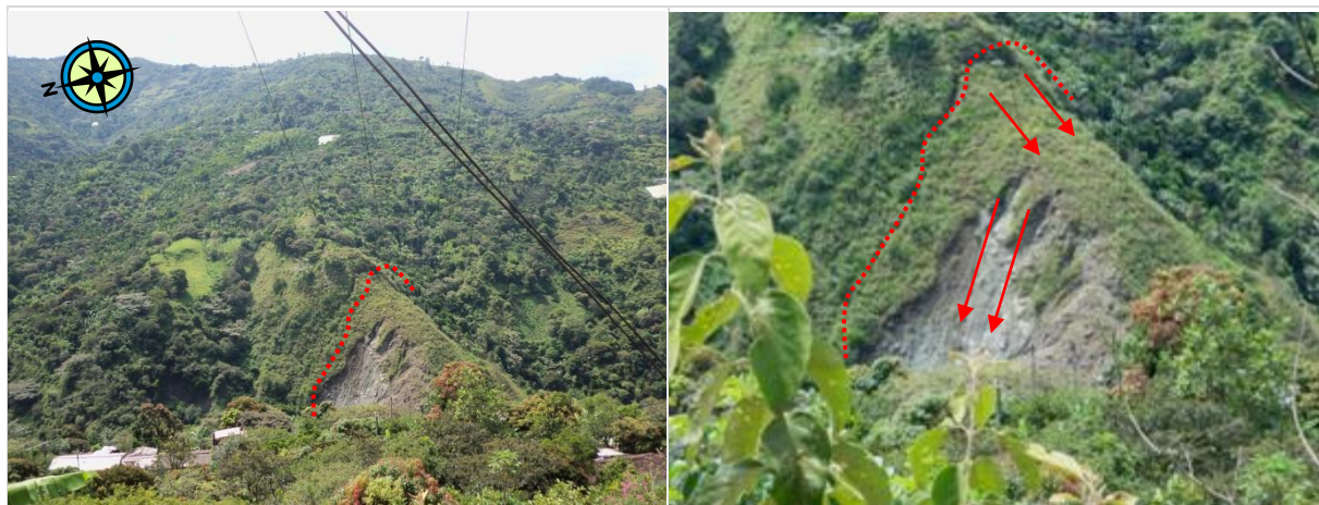
Fotografías 01 y 02. Vista en dirección W-E. EVENTO 01. Panorámicas del deslizamiento. Se indica la fisura arriba de la corona del movimiento, al contorno de la masa deslizada y la dirección del movimiento.
