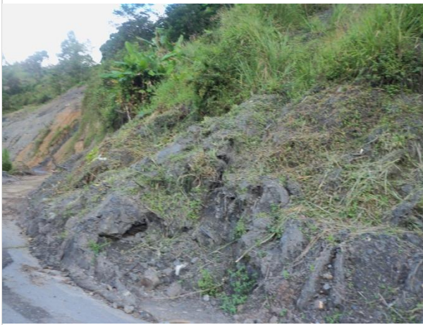
Fotografía 25 y 26. Panorámica en dirección SE-NW. EVENTO 14. La altura del evento es de 5.0 m. se desarrolla longitudinalmente en 61.0 m. El movimiento corresponde a una masa de 241.0 m 3 , ocupa un área de 366.0 m 2 .
