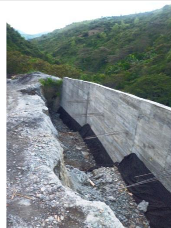
Fotografía 40. EVENTO 34. Panorámica N-S. Sitio de construcción de la estructura de contención en el sector.
