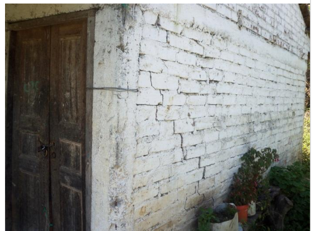
Fotografías 49 y 50. Vivienda Señora. Flor Chávez. Corresponde a una construcción de un piso con muros en ladrillo común, se observó algunas columnas y vigas de corona en concreto reforzado. La vivienda presenta fisuramiento en muros.
