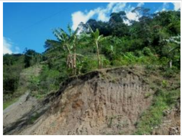
Fotografía 68. Panorámica del talud en dirección W – E. EVENTO 02.
