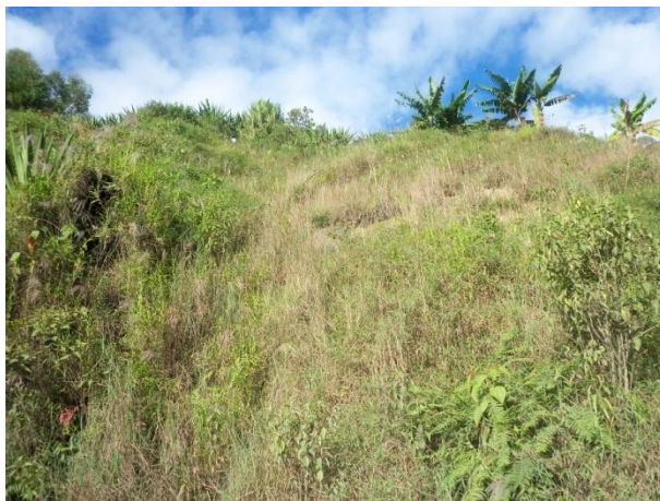
Fotografía 69. Panorámica de la ladera en deslizamiento en dirección W _ E. EVENTO 22. Vereda Campo Bello.
