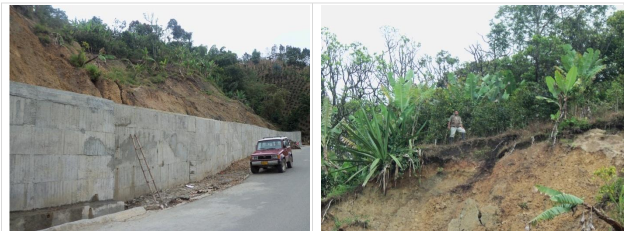
Fotografía 07 y 08. Panorámica en dirección N-S. EVENTO 07. El deslizamiento se ha estabilizado mediante la construcción de un muro de contención en concreto reforzado de 3.0 m de altura y una longitud de 65.0 m.
