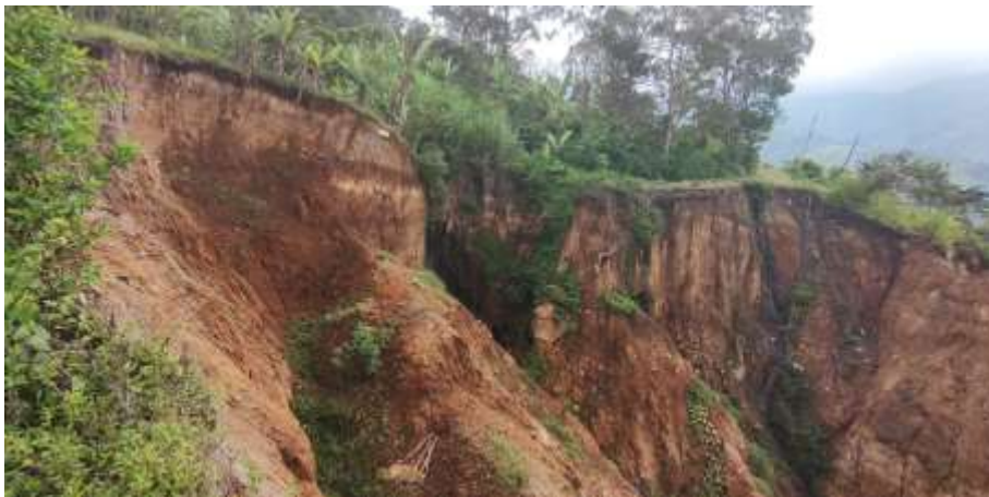
Figura 87 Deslizamiento rotacional complejo, donde se encontraba la vía que comunica a la vereda La Planeta con la vereda El Hatillo, se evidencia saturación del suelo y vertimientos directos a la ladera.
