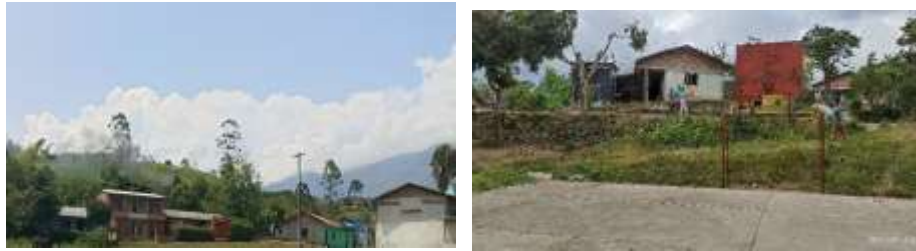
Figura 48 Viviendas de concreto e infraestructura, sector rural
