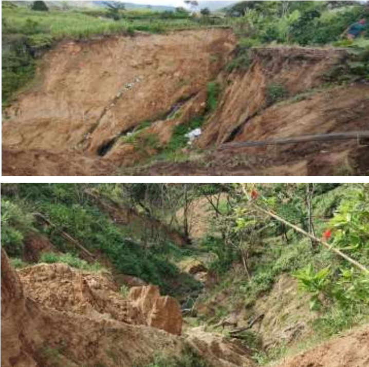
Figura 52 Deslizamiento rotacional retrogresivo complejo.
