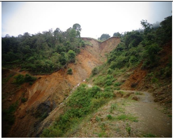
Evento 10. Deslizamiento traslacional.
