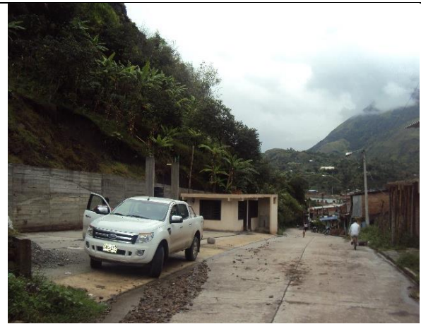
Evento 42. Estación de servicio y viviendas ubicadas en la parte baja de la ladera.
