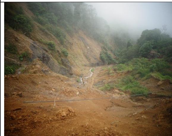
Evento 10. Material arcilloso con alto contenido de humedad.
