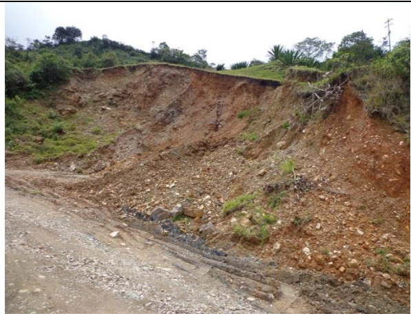
Evento 32. Afloramiento de aguas subterráneas
