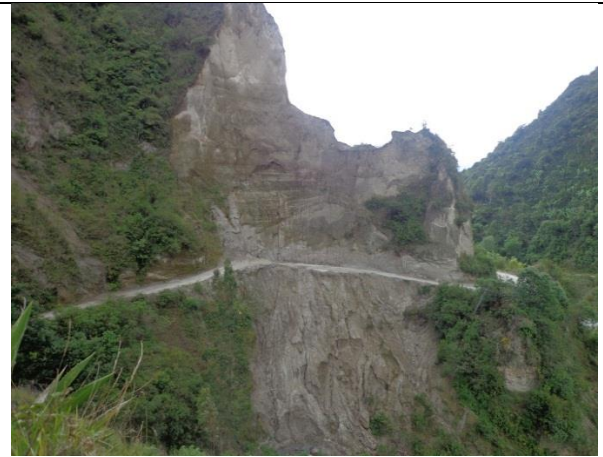
Evento 27. Deslizamiento traslacional
