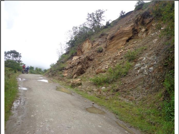
Evento 18. Deslizamiento rotacional
