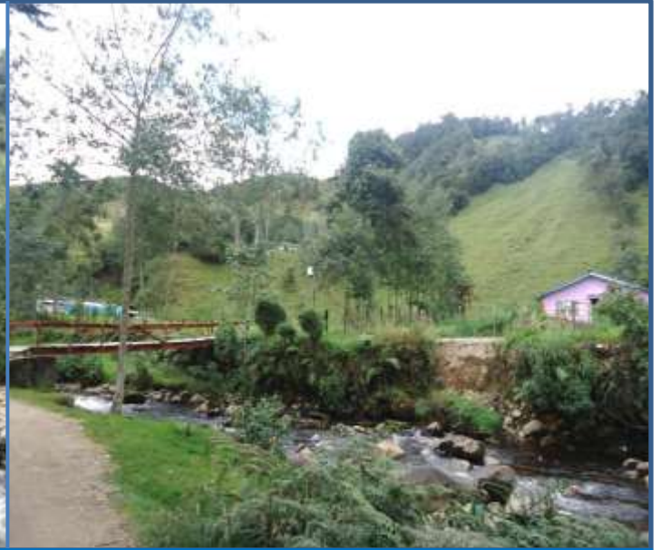
Figura 40. Viviendas ubicadas sobre depósitos de antiguas avenidas torrenciales y puente en posible riesgo.
