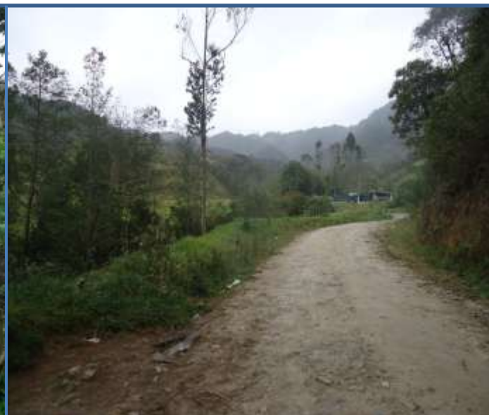
Figura 49. Vía localizada al margen derecho del Río Motilón expuesta en su mayoría a inundaciones.
