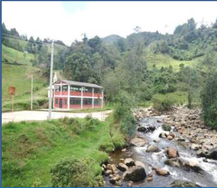
Figura 41. Edificaciones localizadas en terraza aledaña al cauce del Río Encano y vía afectada por socavación lateral.
