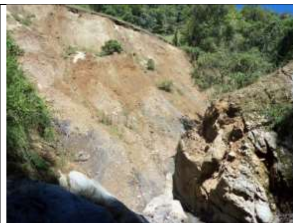
Evento 28. Deslizamiento Rotacional.
