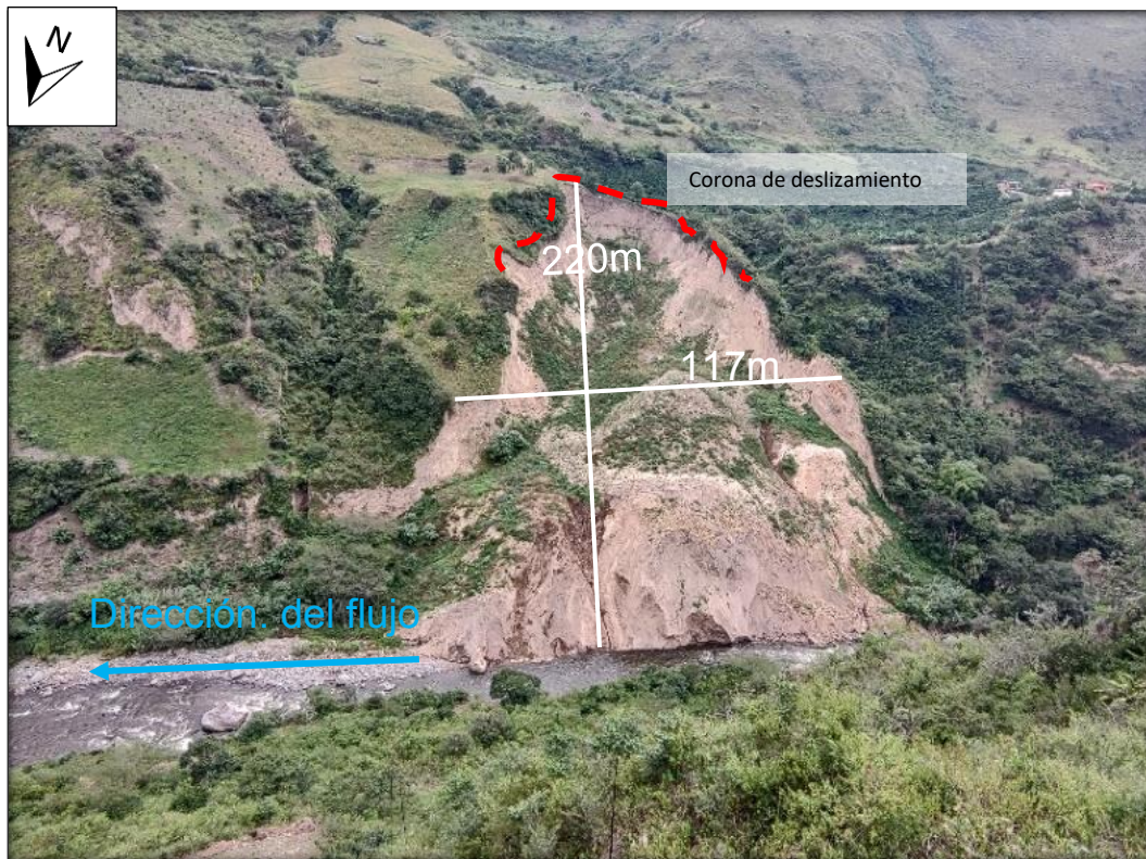
Figura 26 Movimiento en masa en inmediaciones del Corregimiento de El Pedregal, jurisdicción del municipio de Funes (coordenadas de referencia: 1° 2'42.14"N, 77°27'9.38"W).
