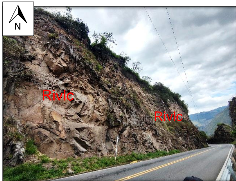
Figura 18 Fotografía tomada en la vía antigua Pasto – Ipiales (Coordenadas: 0°57'10.7"N, 77°28'08.4"W), se evidencia Roca intermedia volcánica de lavas y cenizas (Rivlc).
