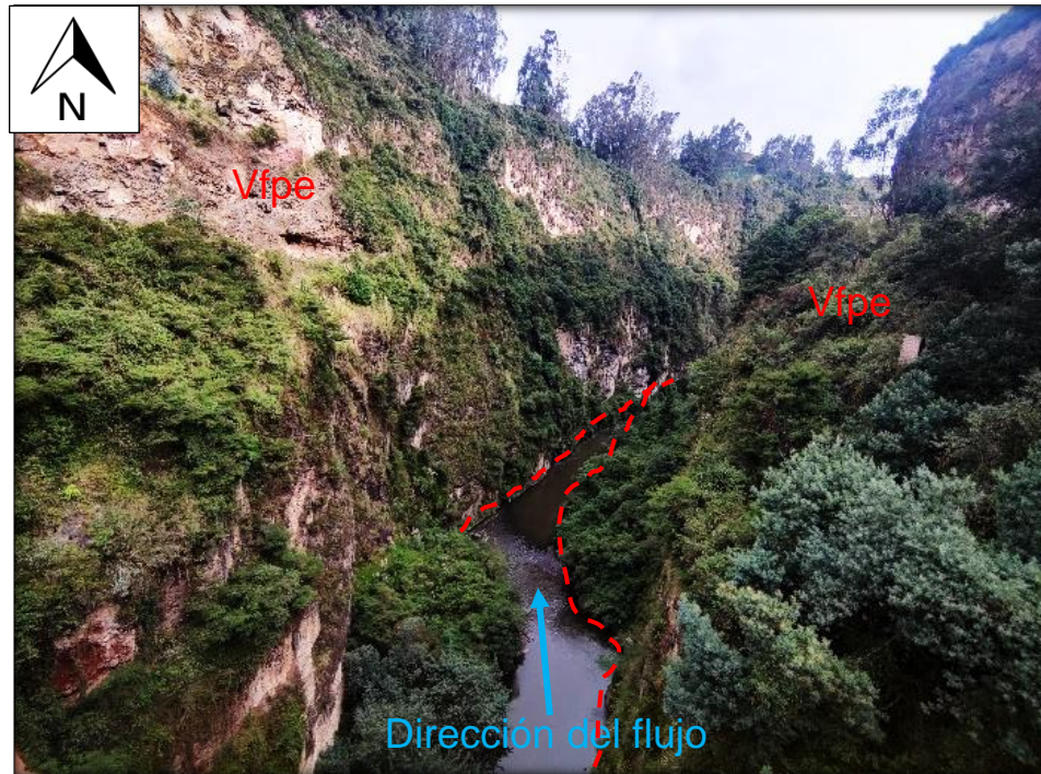
Figura 9 Fotografía tomada en el puente que conduce de Ipiales al municipio de Potosí (coordenadas: 0°48'21.25"N, 77°34'44.04"W ), se evidencian Escarpes de flujo piroclástico aterrazado (Vfpe), donde se aprecia el encañonamiento del río Guáitara.
