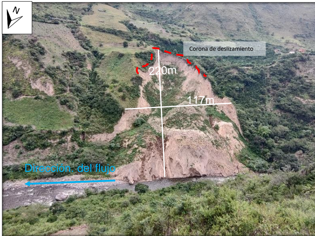
Figura 26 Movimiento en masa en inmediaciones del Corregimiento de El Pedregal, jurisdicción del municipio de Funes (coordenadas de referencia: 1° 2'42.14"N, 77°27'9.38"W).
